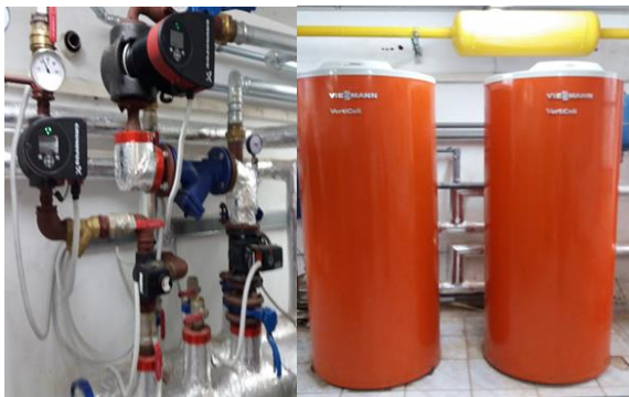
Rysunek 10. Modernizacja instalacji CO w budynku szkoły Zespołu Szkół Ogólnokształcących i Zawodowych w Lwówku Śląskim – zadanie realizowane przez Powiat Lwówecki
