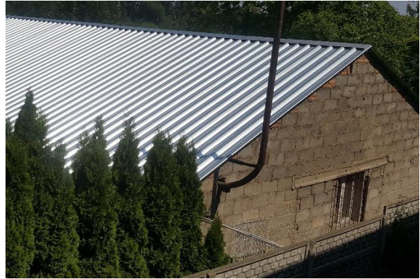
Rysunek 14. Demontaż i utylizacja azbestu - pokrycie dachowe w miejscowości Spalice w Gminie Oleśnica
