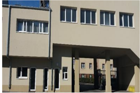
Rysunek 9. Głęboka termomodernizacja energetyczna budynku hotelu przy ul. Złotniczej 12 w Jeleniej Górze – zadanie realizowane przez Termę Cieplickie Sp. z o.o.
