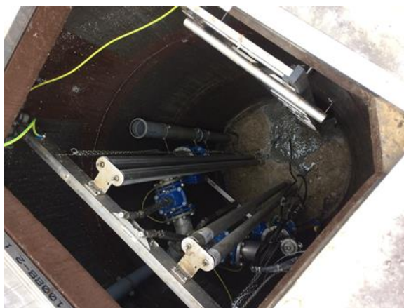
Rysunek 3. Przebudowa przepompowni ścieków w miejscowości Krzeczyn Wielki, Krzeczyn mały i Gorzyca, na terenie Gminy Lubin – zadanie realizowane przez Gminę Lubin.
