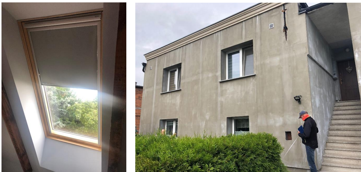
Rysunek 8. Termomodernizacja budynku, wymiana stolarki okiennej.
