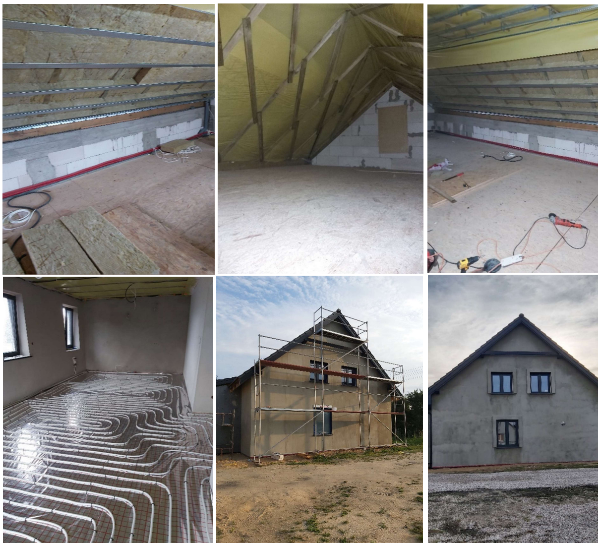
Zdjęcie 8. docieplenie przegród budowlanych, instalacja centralnego ogrzewania.
