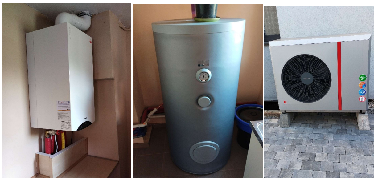
Zdjęcie 9. wymiana źródeł ciepła
