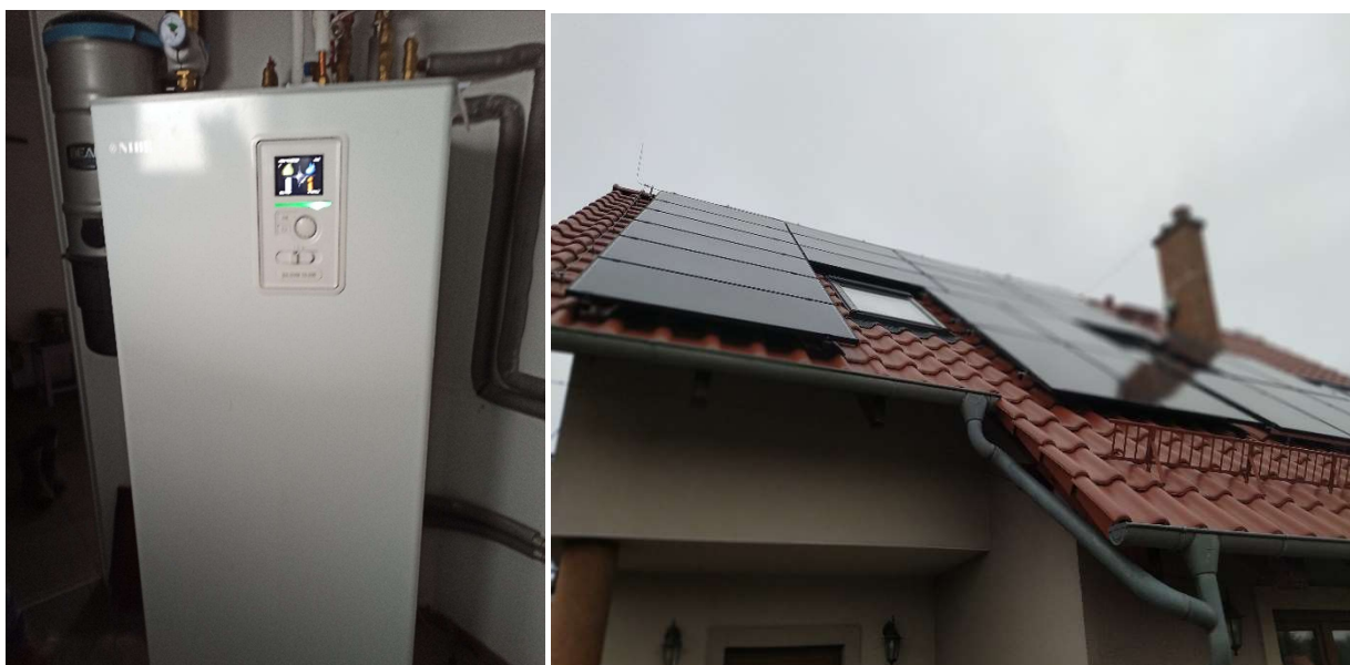
Zdjęcie 7. wymiana źródła ciepła, mikroinstalacja fotowoltaiczna.
