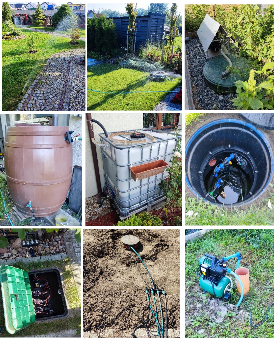
Rysunek 9. instalacje do zbierania, magazynowania i wykorzystania wód opadowych zrealizowane w ramach Programu Priorytetowego Moja Woda.
