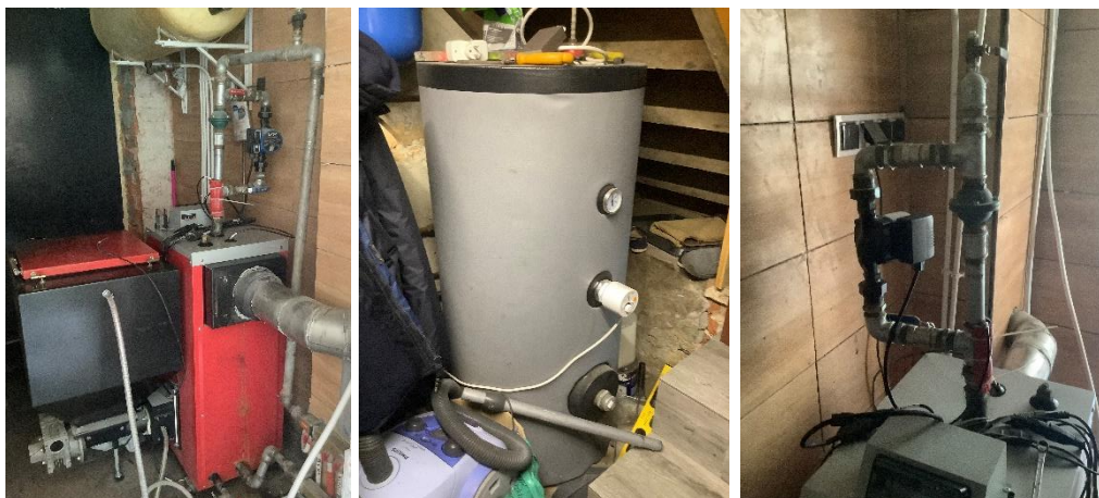
Rysunek 10. wymiana źródeł ciepła – zadania realizowane w ramach Programu Priorytetowego Czyste Powietrze.
