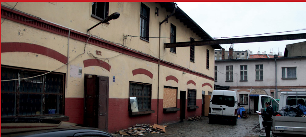
Rysunek 19. Budynek publiczny przed (A) i po termomodernizacji (B) (fot. Jerzy Żurawski)
